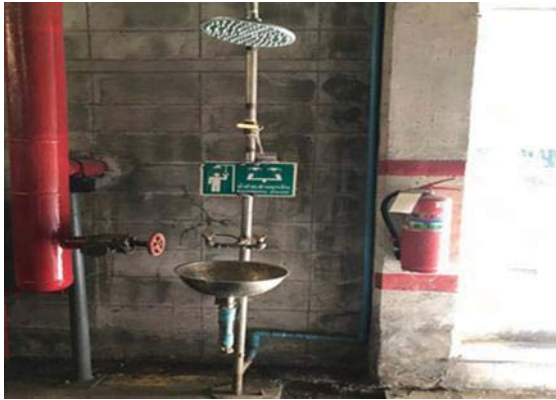
ภาพที่ 29 อ่างล้างตาและร่างกายฉุกเฉิน
