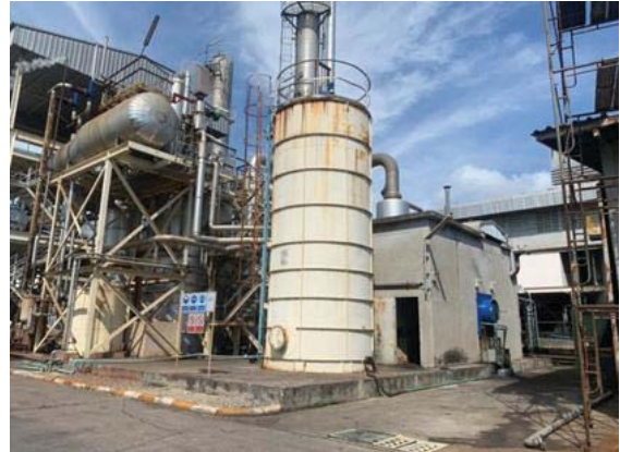
ภาพที่ 8 ถังเก็บกักน้ำขนาด 75 ลบ.ม.
