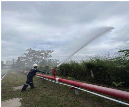
ภาพที่ 31 Fire monitor ที่ถังบรรจุน้ำมัน
